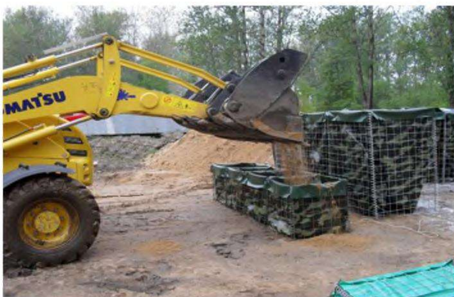
Рисунок V.52 - Процесс наполнения яруса габионов типа «ГНТ»
