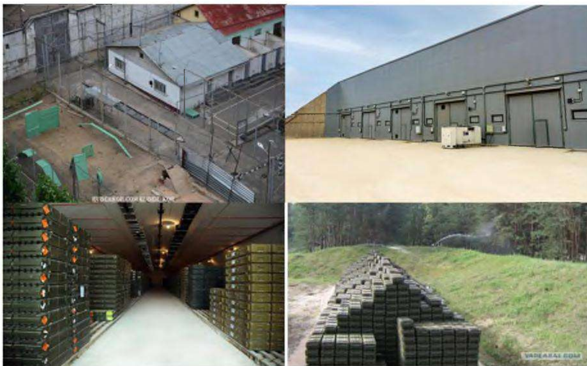
Рисунок IV.22- Фрагменты зданий и мест хранения боеприпасов на стационарных складах РАВ
