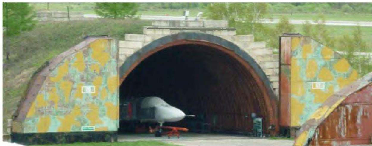
Рисунок V.70 – Пример прямого входа в укрытие для самолётов, оборудованного защитным затвором
