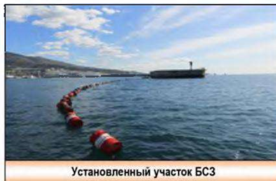
Рис. № 15 Установленный участок БСЗ
