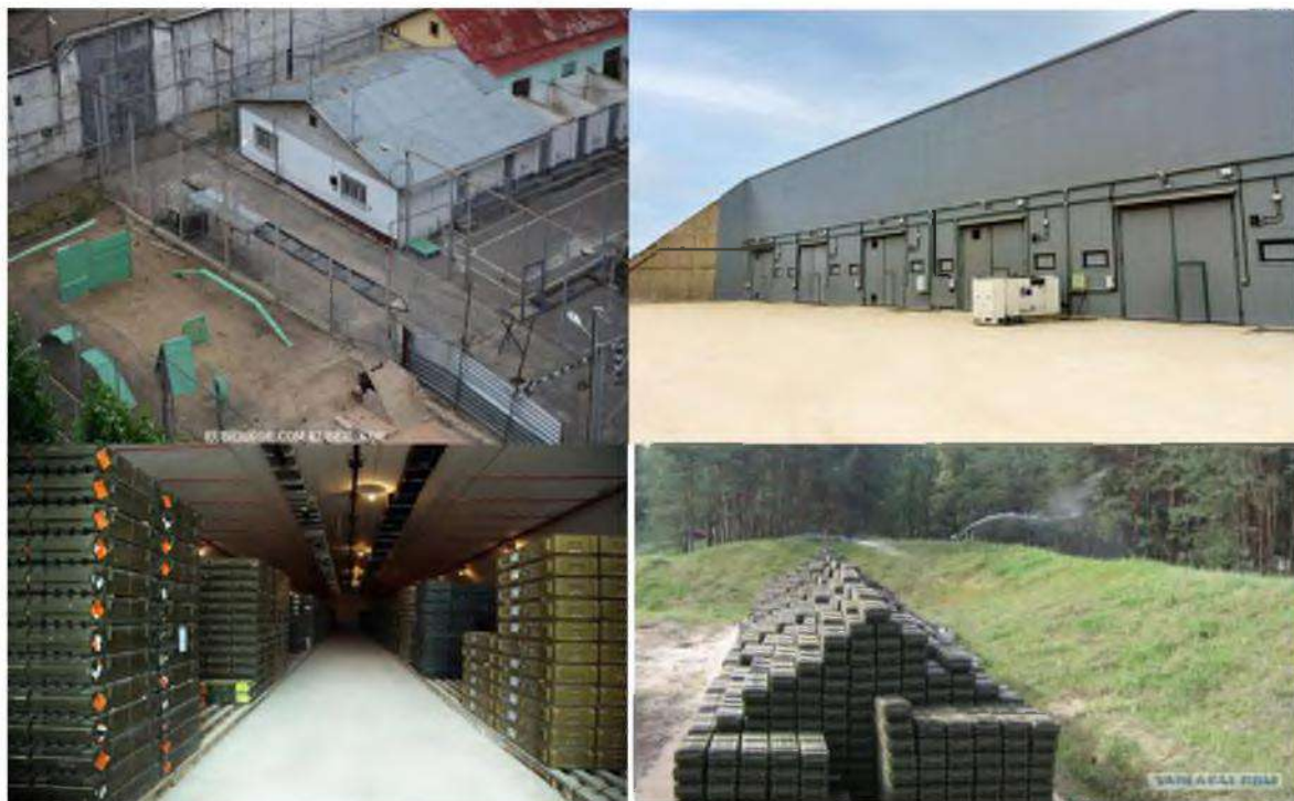
Рисунок 1.3 - Фрагменты зданий и мест хранения боеприпасов на стационарных складах РАВ
