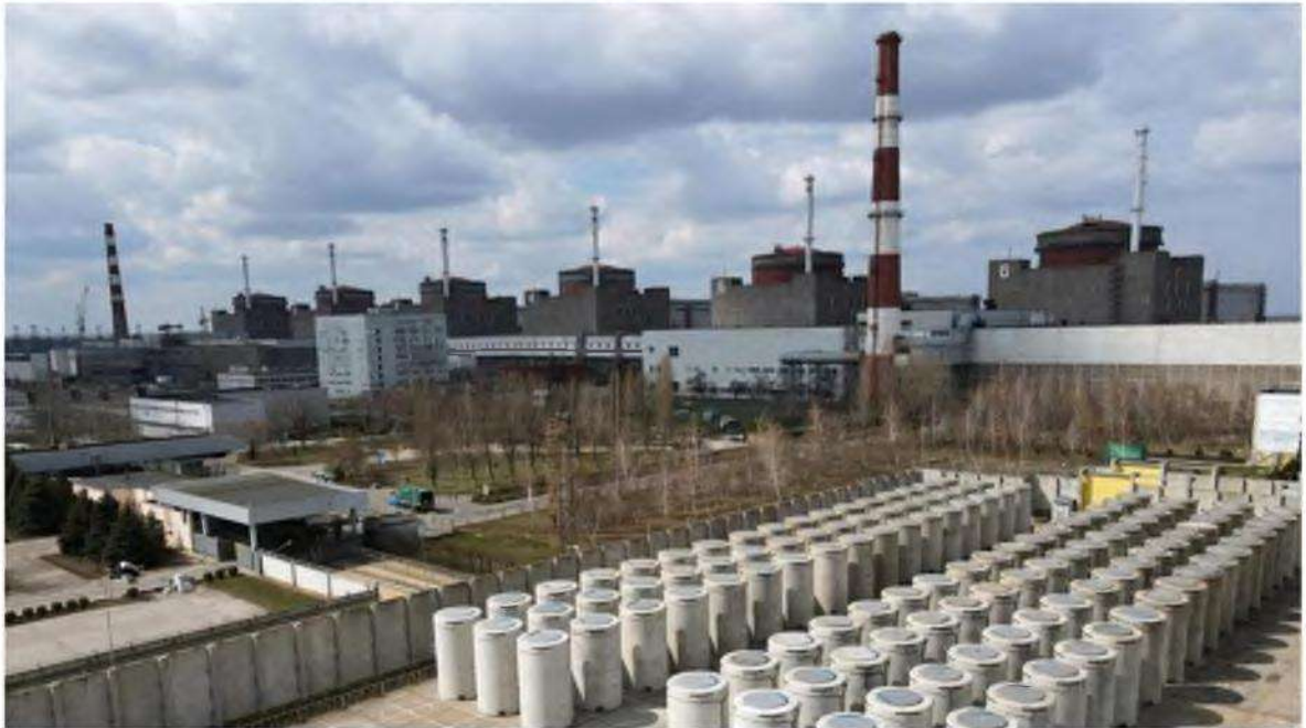
Рисунок IV.38 - Схема открытого расположения контейнеров с радиоактивными отходами на Запорожской АЭС
