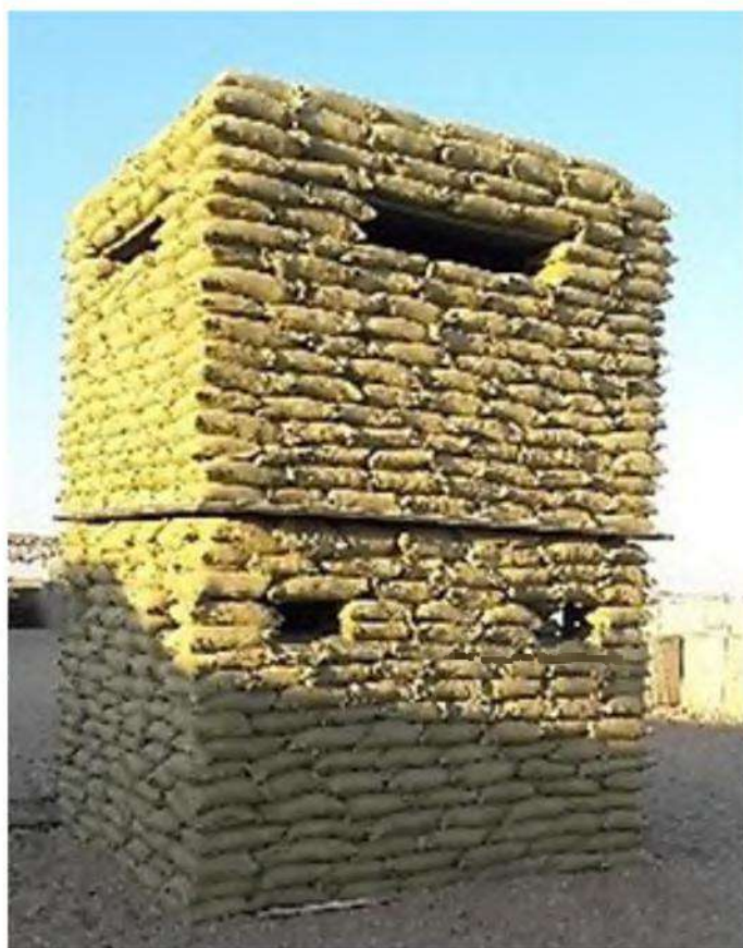
Рисунок IV.49 – Сооружение для наблюдения и ведения огня (Вышка), располагаемое в системе ТСО ПОО
